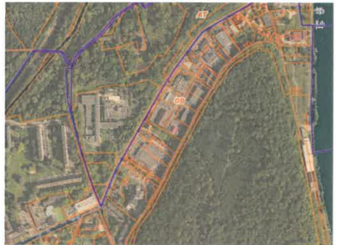
Vue aérienne de la zone d'activité économiques de Valvins
